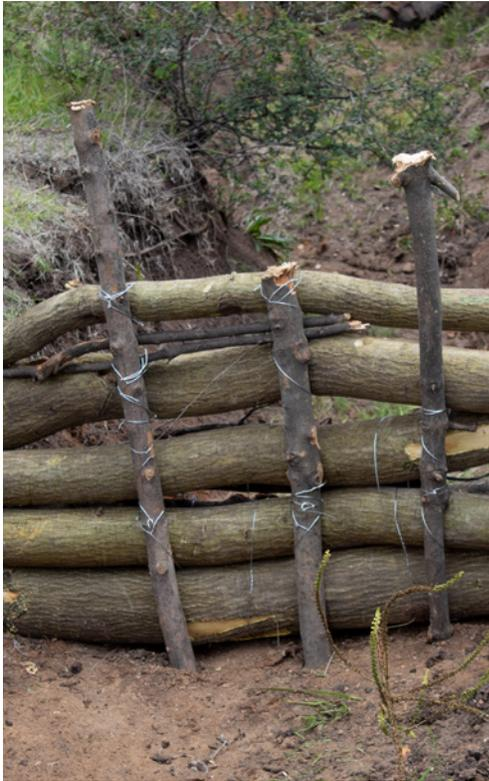
Presa de ramas para la retención del suelo en “Barranca Tarango”,
